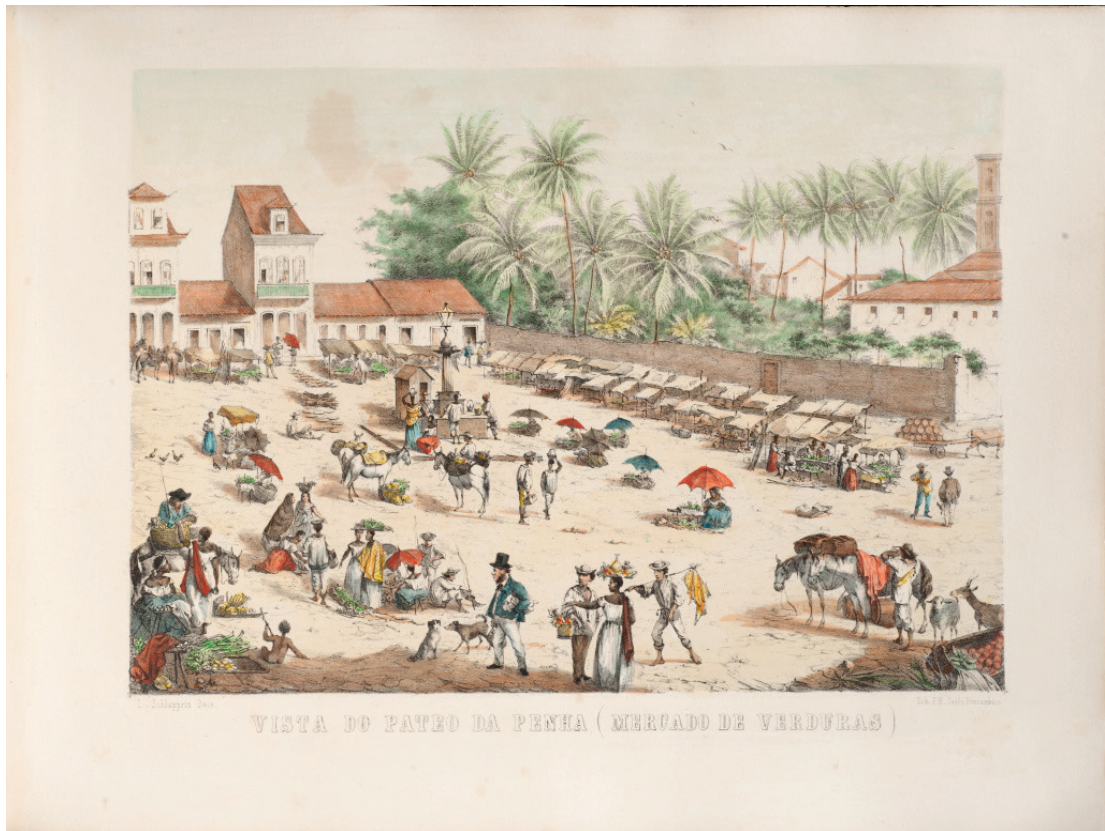
Figura 13 - Vista do Pateo da Penha (Mercado de Verduras)
