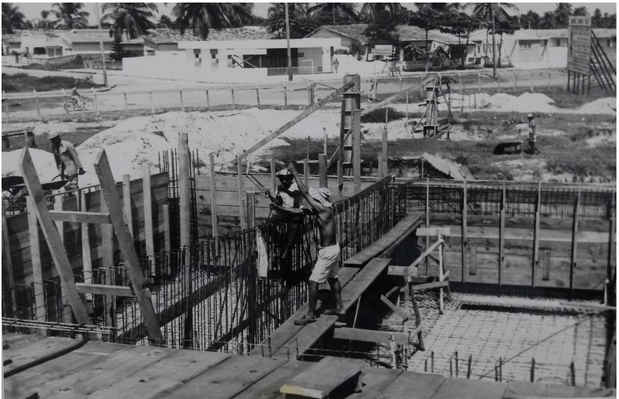
Imagem 2 – homens trabalhando na construção do Estádio de Rei Pelé (2):
