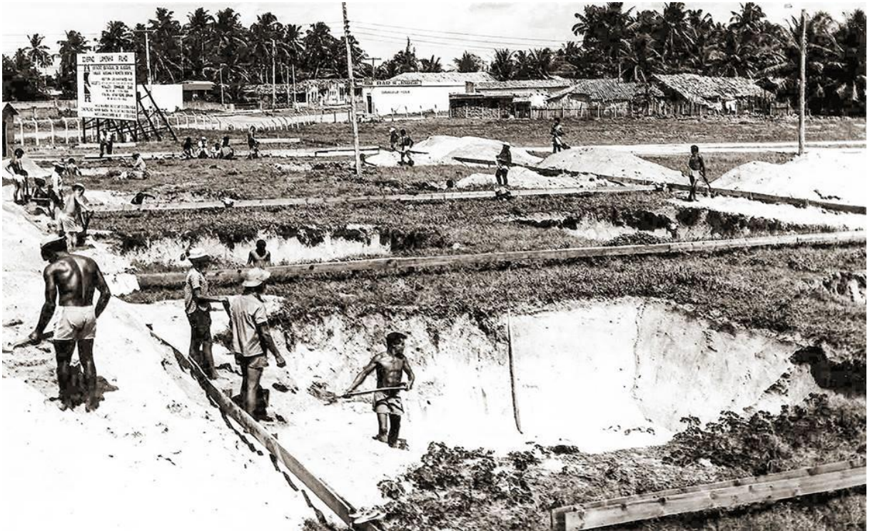
Imagem 1 – homens trabalhando na construção do Estádio de Rei Pelé (1):
