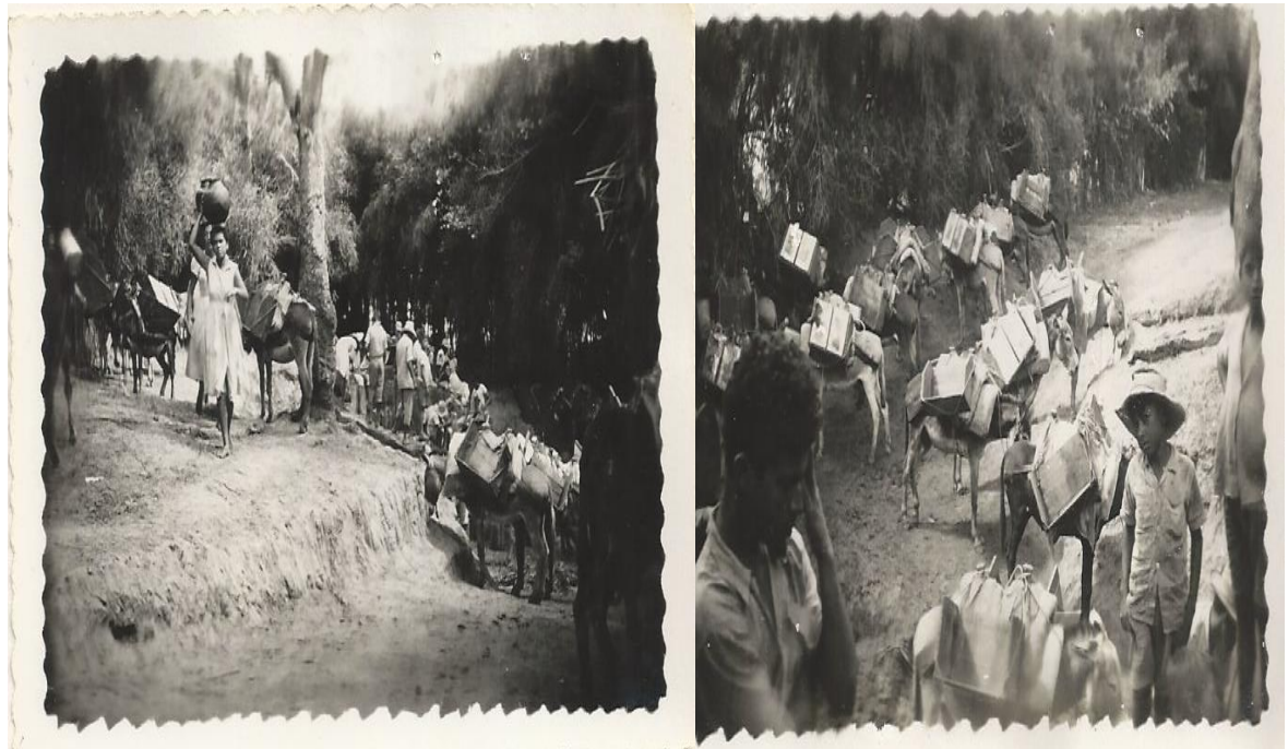
Fotografia 14: Abastecimento de água em Palmeira dos Índios (1940) com água do açude na Mata da Cafurna
