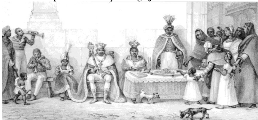
IMAGEM 6 - Coleta para a manutenção da Igreja de Nossa Senhora do Rosário (1828)
