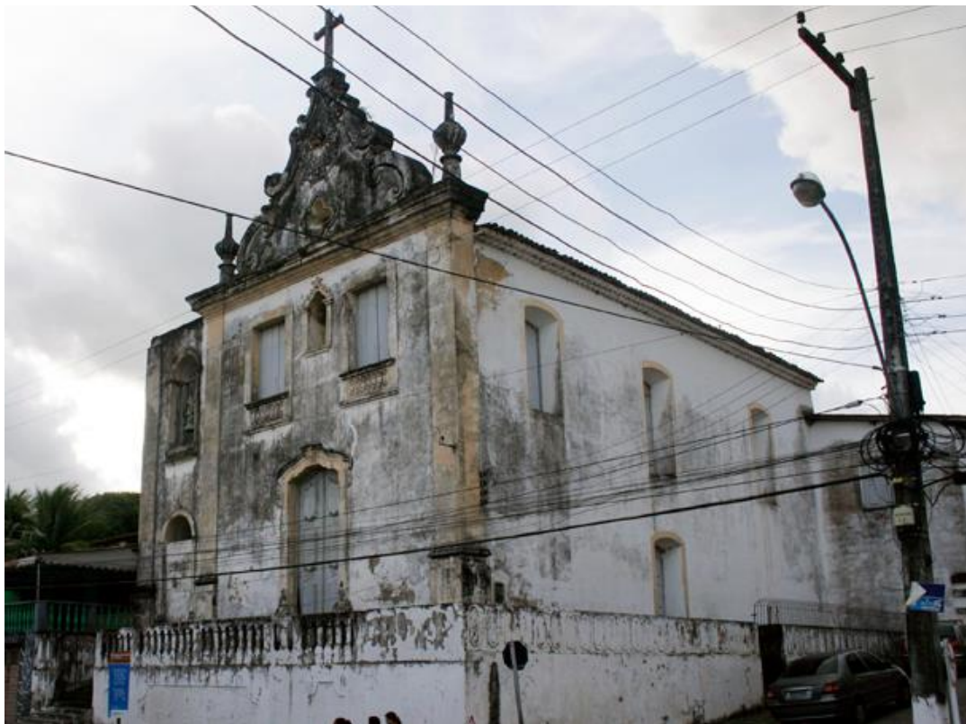
Igreja de Nossa Senhora do Amparo, Marechal Deodoro.
