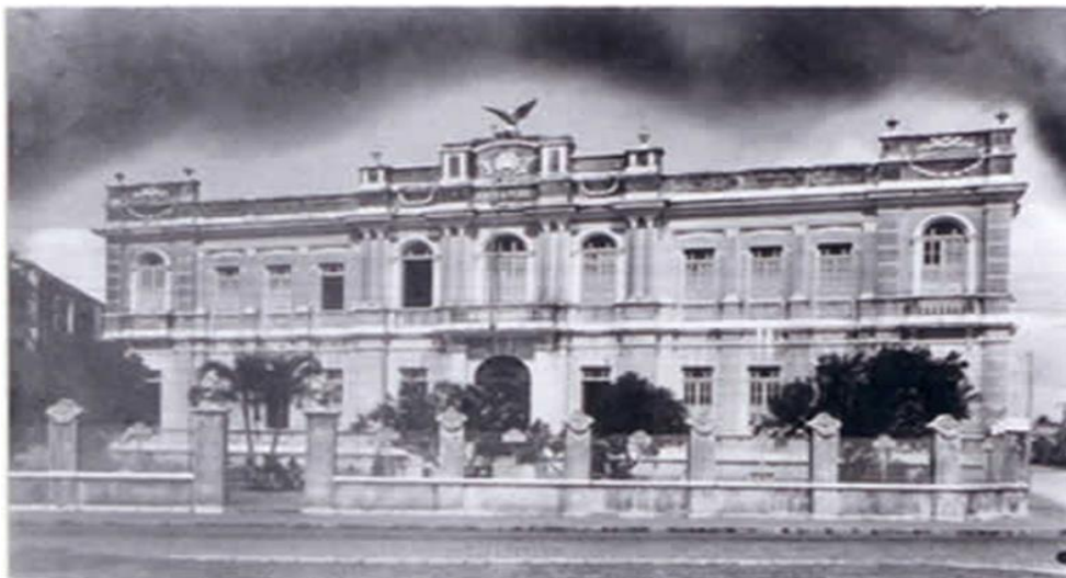
Figura 25 – Prédio do Atheneu Pedro II
