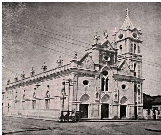
Figura 34 – Igreja de São Salvador recém-reformada
