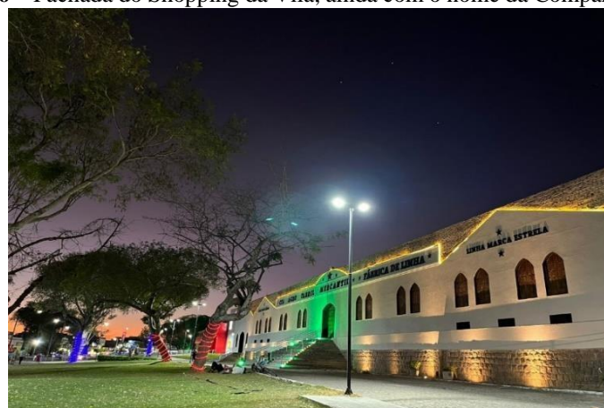
Figura 6 – Fachada do Shopping da Vila, ainda com o nome da Companhia.
